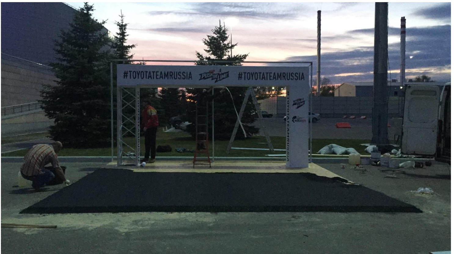
Нанесение финишного покрытия – резиновая крошка.
