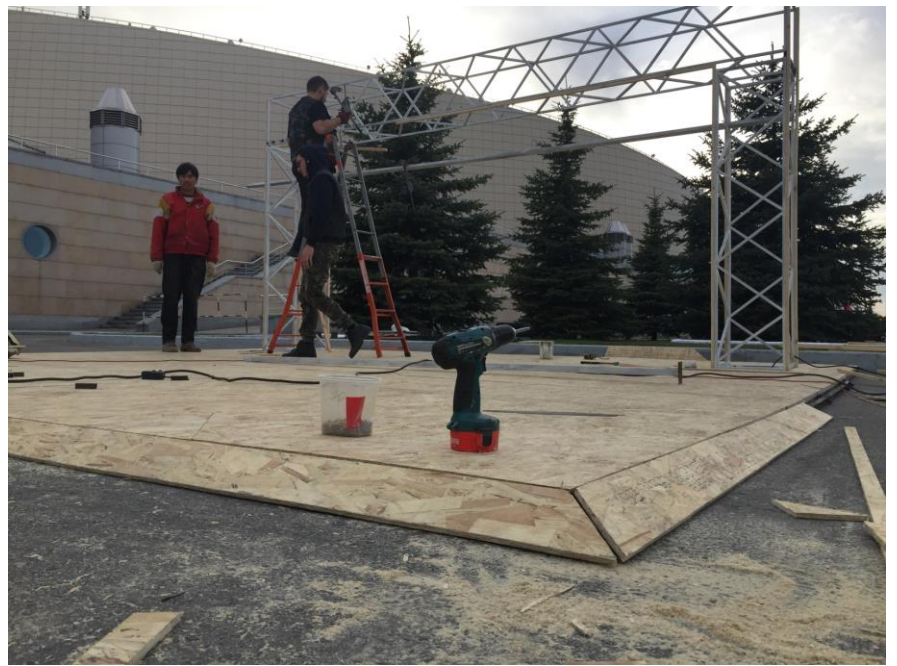
Сборка на обьекте.
