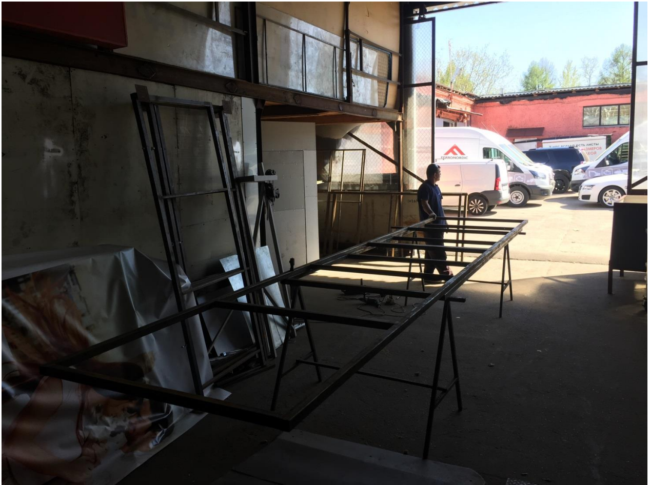
Модуль сварного каркаса подиума.
