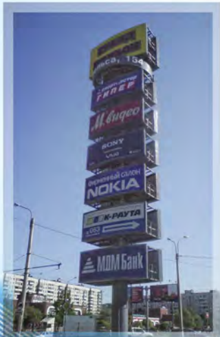
высотные монтажные работы
